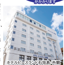
ホテルピースランド石垣島/外観
