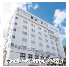
ホテルピースランド石垣島/外観
