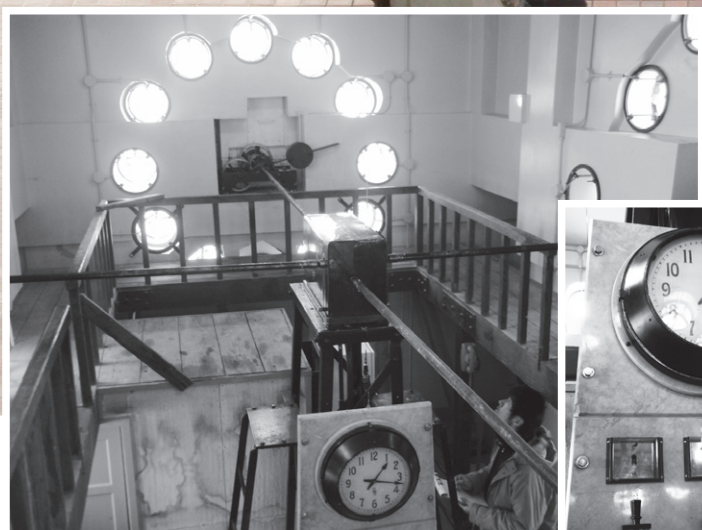
▲時計台最上層。四方の大時計の針は部屋の真ん中上部の駆動部分・モーターとつながっており、右の写真の時計が、四方の大時計の動きを司っている。また、電波時計も備えているため、高い精度を誇っている。
