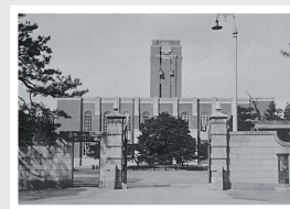
▲時計台が竣工して間もないころの初代クスノキ。
