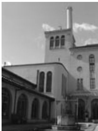
▲センターの中庭から
