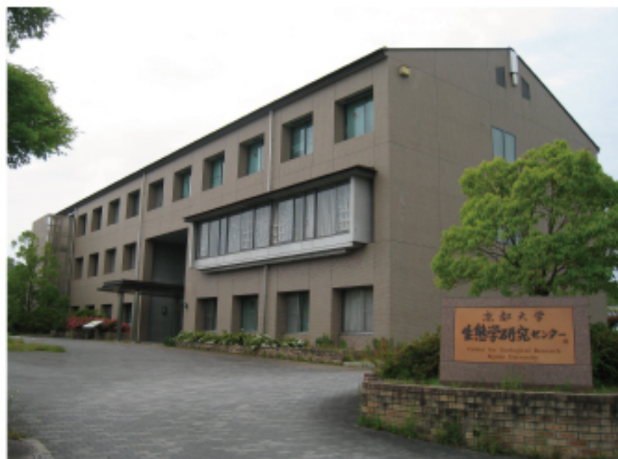
1998年10月（平成10月）に現在のセンター研究実験棟（大津市平野）が完成。
